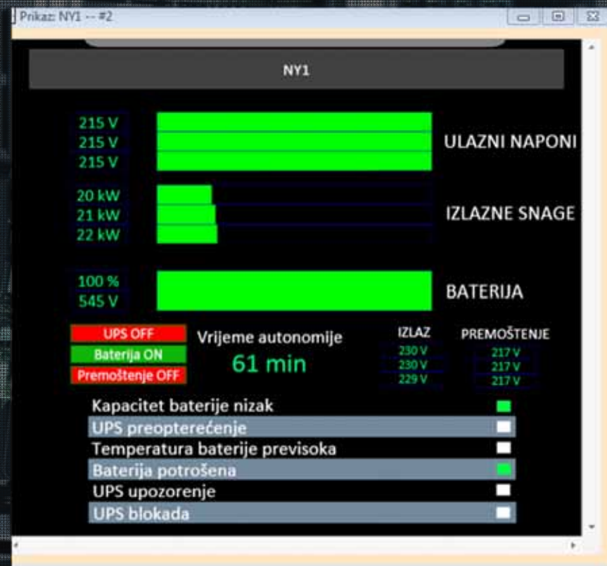
Trofazni ups sustav
